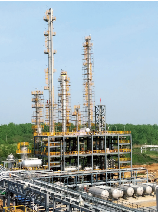
3 万吨/年离子液体催化 CO 2 转化合成 DMC/EG 工业装置
